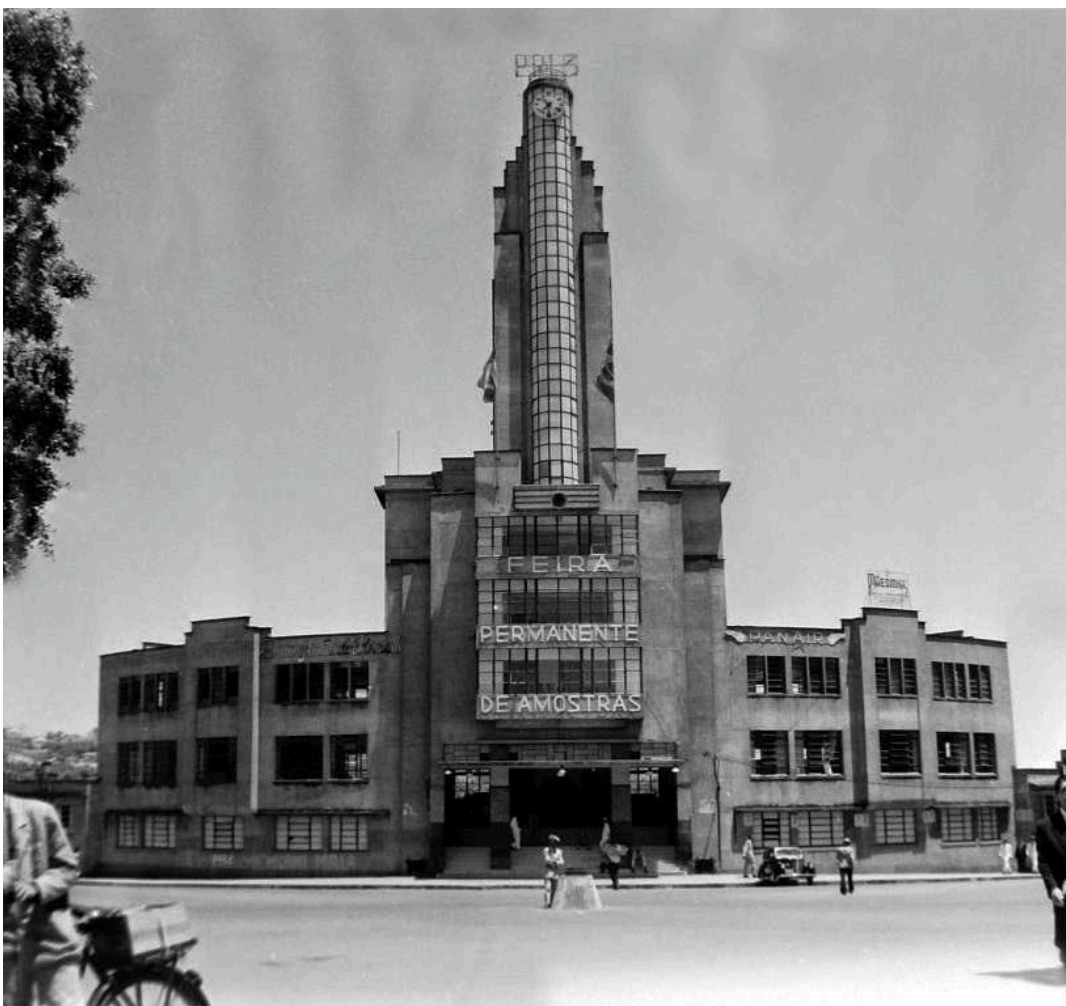
Figura 1: Imagem frontal do prédio da Feira Permanente de Amostras, de elevada torre e relógio, no começo da Avenida Afonso Pena em Belo Horizonte, MG (Fonte: IBGE, sd.).
