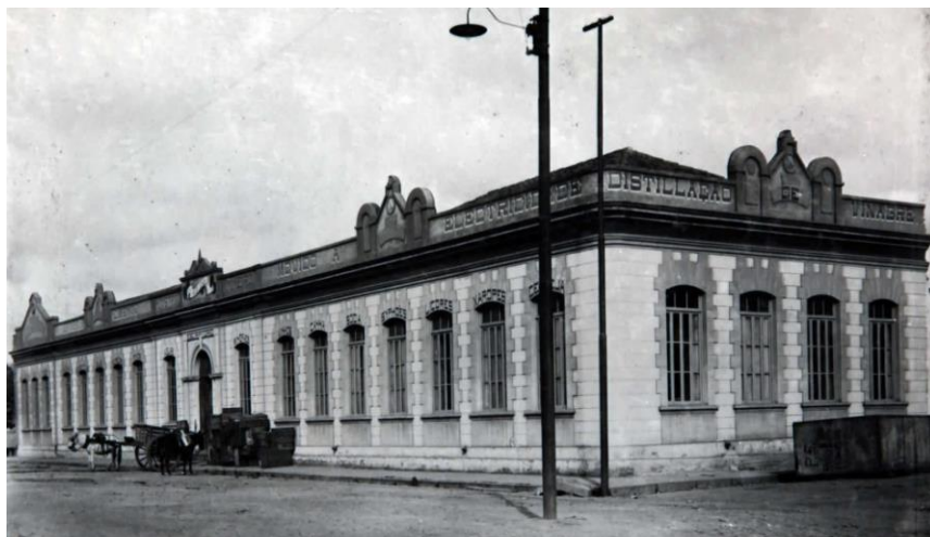
Figura 1.12: Prédio do Estabelecimento Industrial Mineiro em 1911. Em sua fachada é possível identificar as seguintes inscrições: Movido à eletricidade, destilação e vinagre, termos que explicitavam a utilização de técnicas e processamento químico. Fonte: Acervo Iconográfico do Arquivo Público Mineiro
