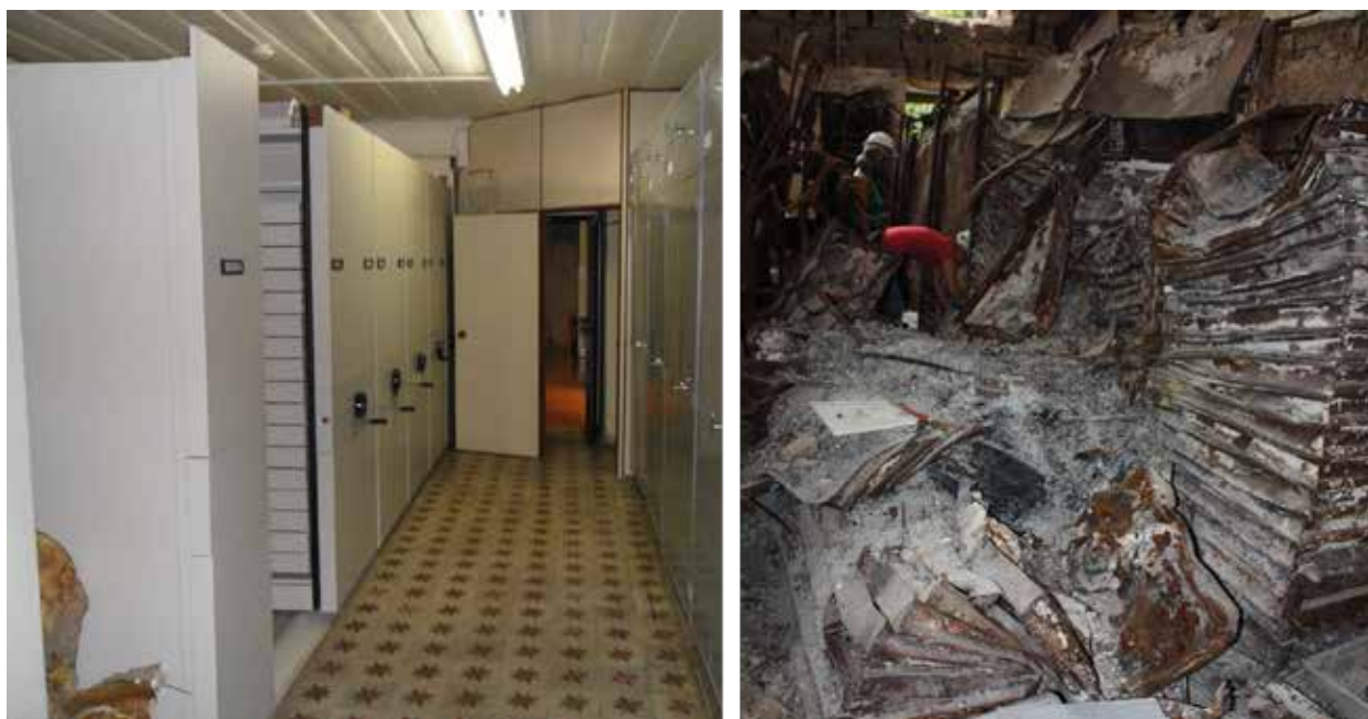
Figura 5.6: armários do setor de mineralogia antes (A, esq.) e depois do incêndio (B, dir.)
